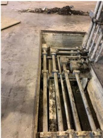
Ispezione tubazioni impianto oleodinamico centralina Trituratori Primari
