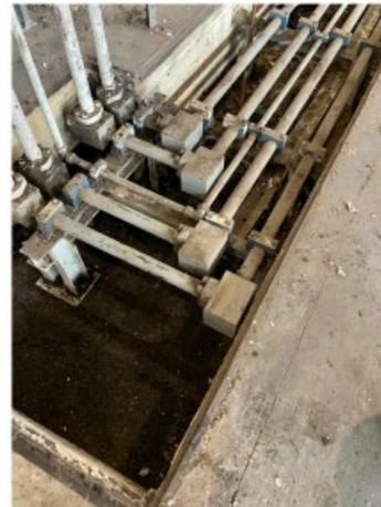
Ispezione tubazioni impianto oleodinamico centralina Trituratori Primari e pulizia canale
